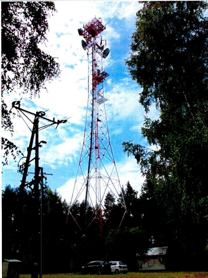
Fot. 1. SLR Wyszków – widok obiektu
